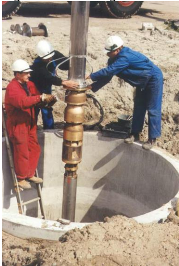
Figuur 2.2 Aanleg van een bron van een open bodemenergiesysteem.
